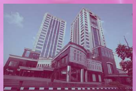
Gedung Kementerian Keuangan
